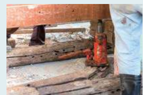
工事現場の安全管理 油圧ジャッキのメーター監視
