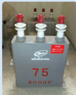
電力用コンデンサー
