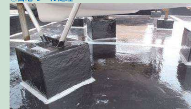
⑧シームレス工法用トップコート塗装・施工完了
