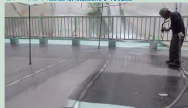
⑦シームレス工法用高強度防水材施工
