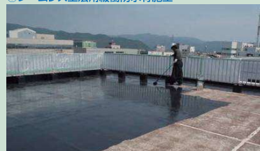
⑦シームレス工法用高強度防水材施工
