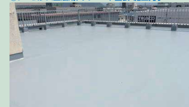
⑧シームレス工法用トップコート塗装・施工完了
