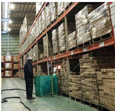
物流倉庫での施工の様子
