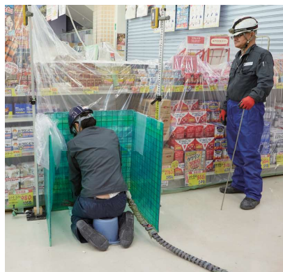
店舗での施工の様子
