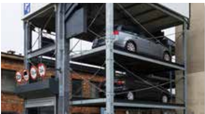
機械式立体駐車場のメンテナンス用
