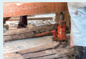
工事現場の安全管理 油圧ジャッキのメーター監視
