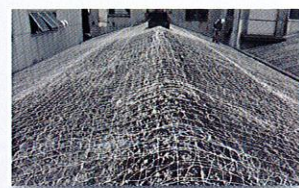
■安全ネットの敷設
