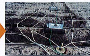
■固定金具の設置
