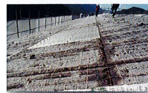
■安全ネットの敷設
