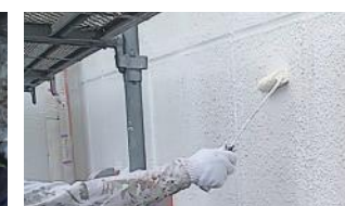
2.プレコーティング(プライマー)
