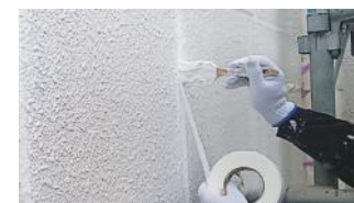
3.テープ処理工法 ※1
