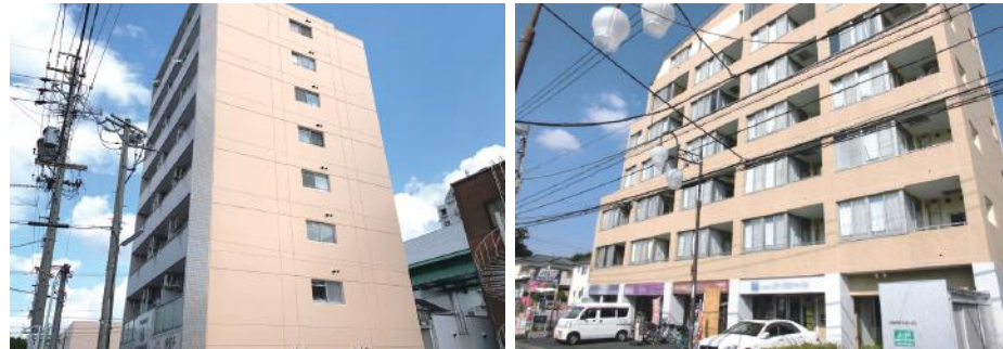
RC造：モルタル・磁器タイル
