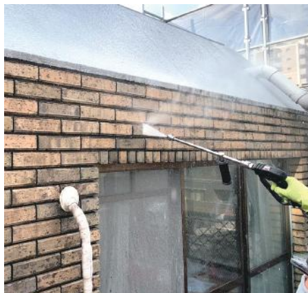
1.高圧洗浄・下地処理
