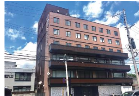
RC造：モルタル
