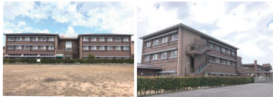
RC造：モルタル
